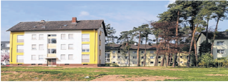
Hier erfolgt am 22. September der erste Spatenstich.
